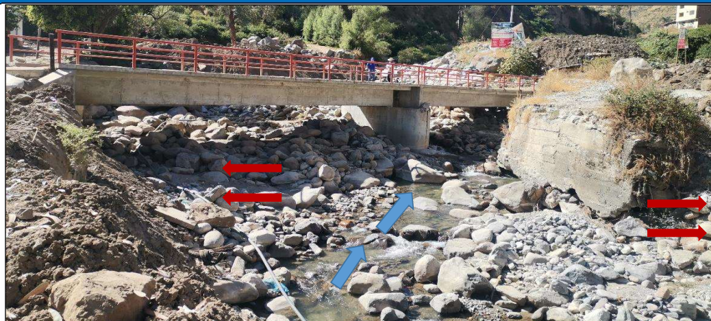
FIGURA N°01: LA QUEBRADA LA PERLA SE ENCUENTRA COLMATADO EN EL SECTOR LA PERLA, CON LA PRESENCIA DE MATERIAL FINO Y GRANULAR; LAS CUALES DEBEN SER DESPLAZADOS HACIA AMBOS MARGENES PARA MANTENER SU SECCIÓN HIDRÁULICA.
