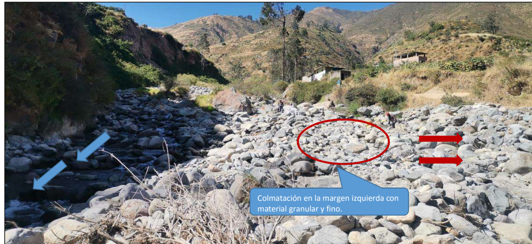
FIGURA N°02: AGUAS ARRIBA DEL PUENTE DE LA QUEBRADA LA PERLA SE ENCUENTRA COLMATADO CON MATERIAL GRANULAR, EN LA MARGEN IZQUIERDA.
