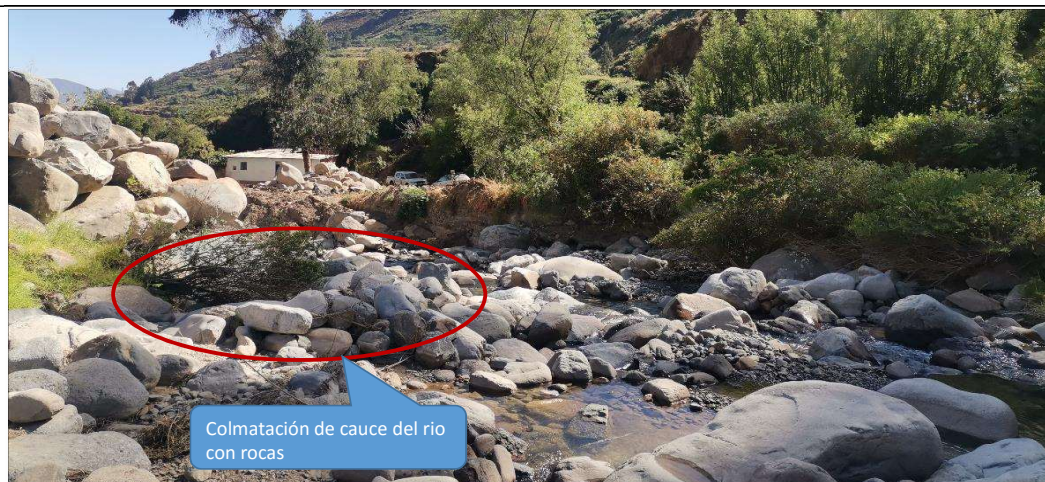
FIGURA N°04: QUEBRADA LA PERLA SE ENCUENTRA COLMATADO CON PIEDRAS DE DIFERENTES TAMAÑOS, OCASIONANDO REDUCCIÓN DE SECCIÓN HIDRÁULICA DEL CAUCE.
